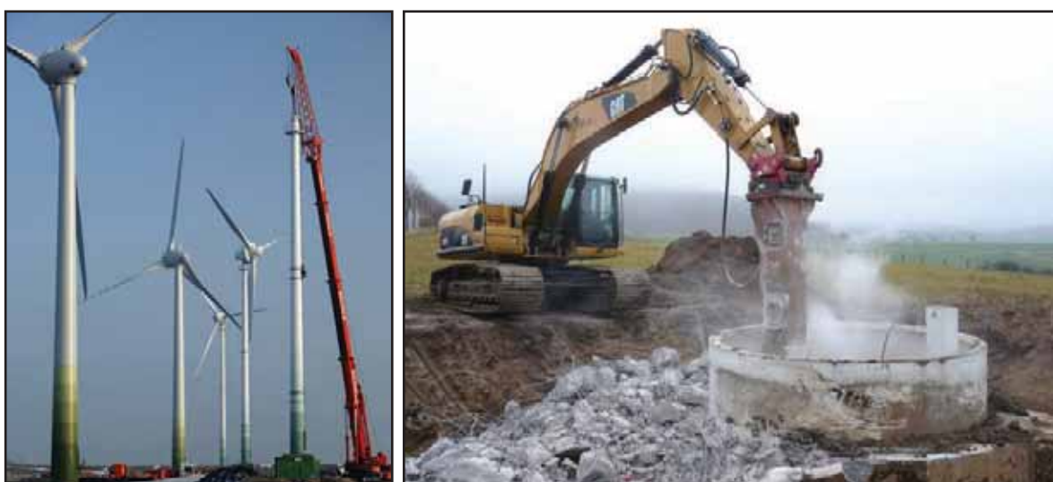
Figure 35: Démantèlement d'une éolienne
