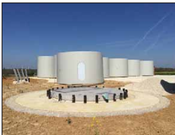
Figure 4: Fondation coulée
