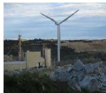
Eolienne de Centernach
