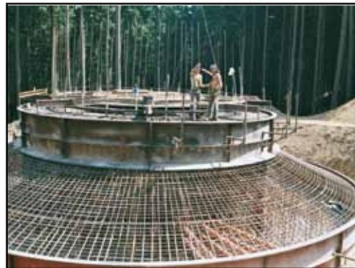
Figure 5: Installation du coffrage
