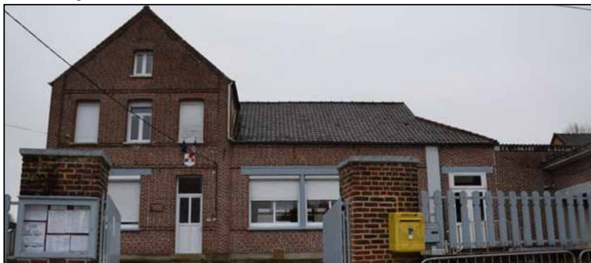
Figure 21: Mairie de Pihem
