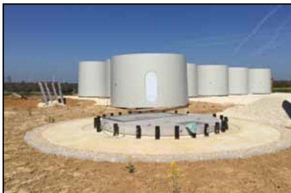
Figure 4: Fondation coulée
