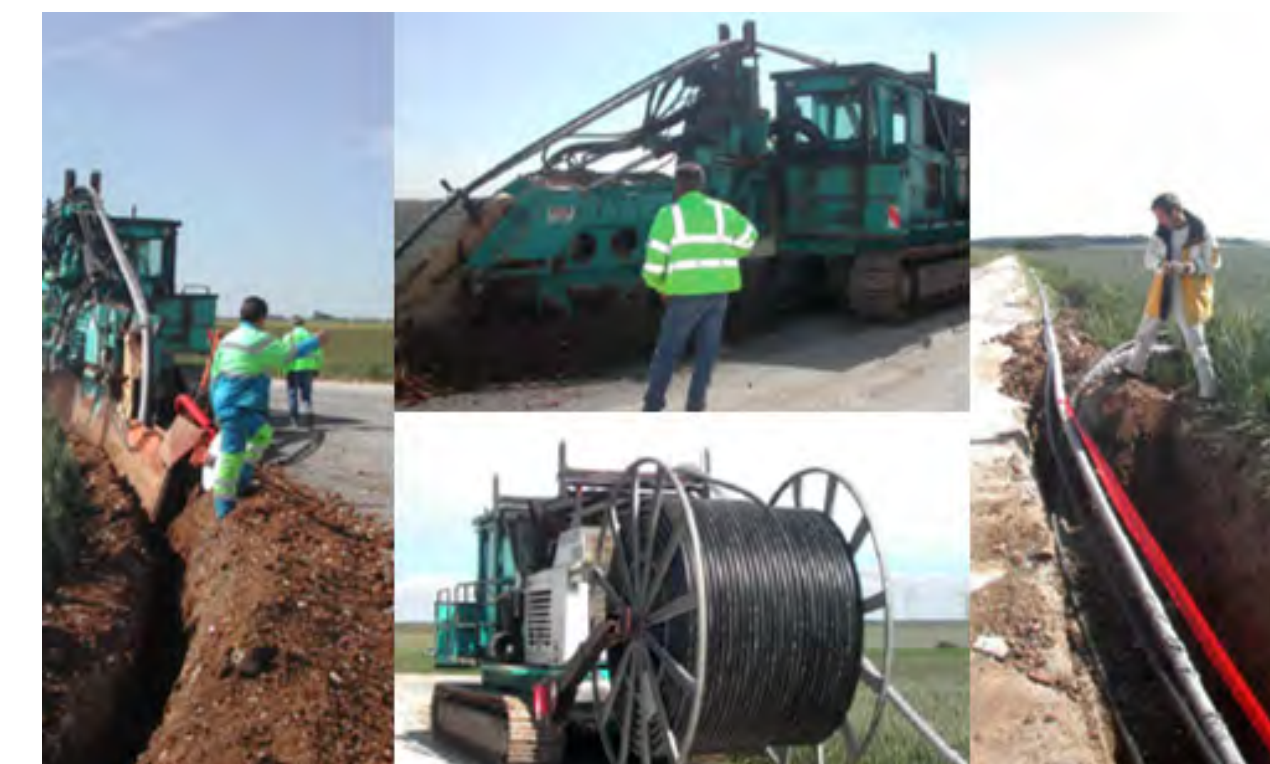
Enfouissement du réseau électrique
