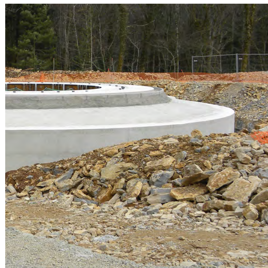
Fondation des éoliennes de grande hauteur de Chamole (198 mètres en bout de pale)
