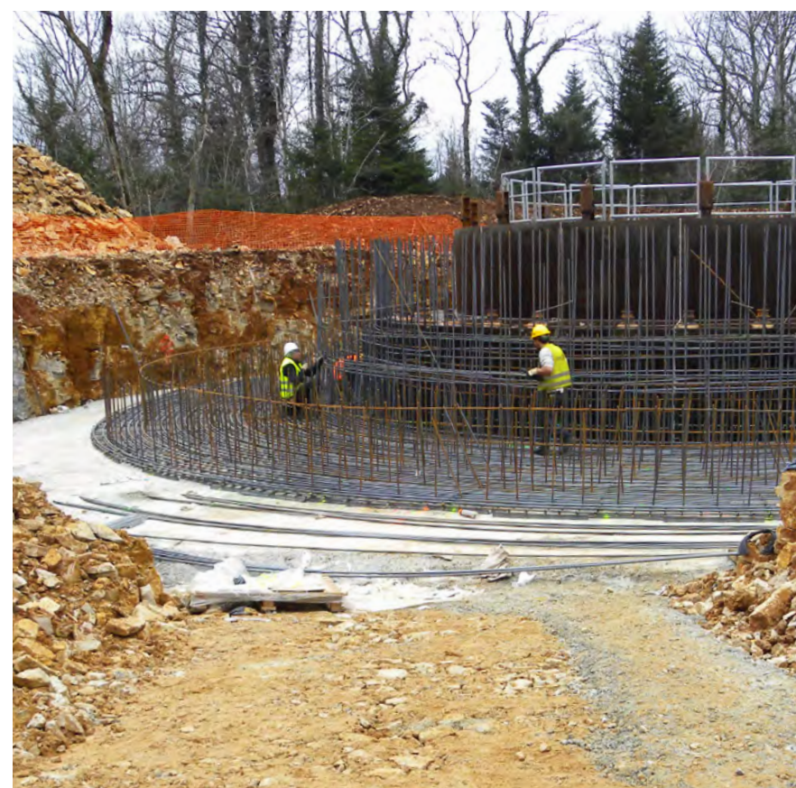
Fondation des éoliennes de grande hauteur de Chamole (198 mètres en bout de pale)
