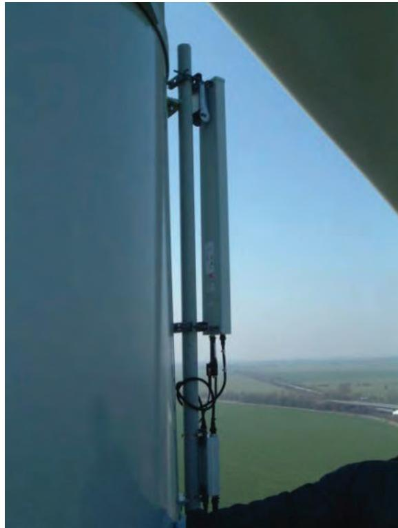
***Antenne de téléphonie mobile sur un mât d'éolienne (photo ENERCON)***
