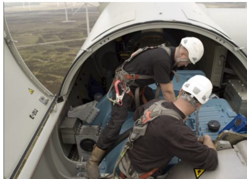
MAINTENANCE DANS LA NACELLE D'UNE ÉOLIENNE (SOURCE LIBRE DE DROIT)
