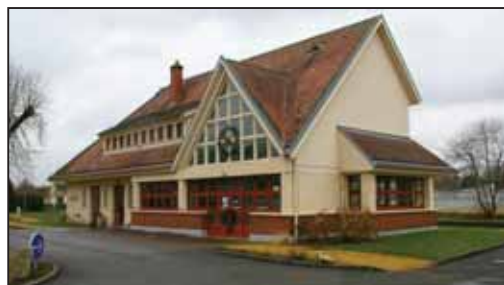
Ancienne gare de Neufchâtel-en-Bray
