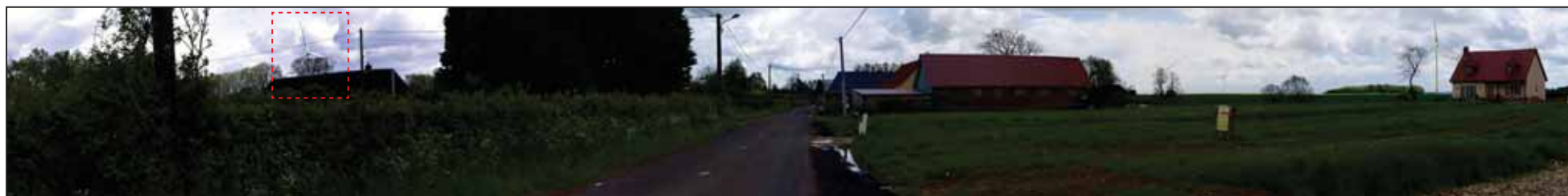
Montage PN 073 étendu et cadrage sur les éoliennes du parc de Callengeville-Preuseville-Smermesnil - Entrée NO de Hambures, sur la D14 - 300 m de la ZDE
