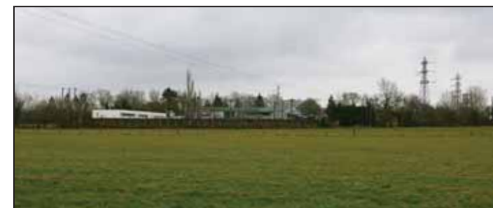
Poste de raccordement de Neufchâtel-en-Bray
