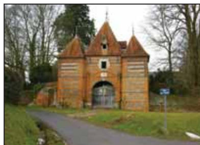
Portail d'entrée du château d'Auvilliers
