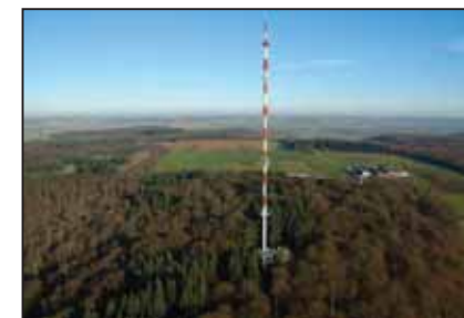
Tour télécom de Croixdalle
