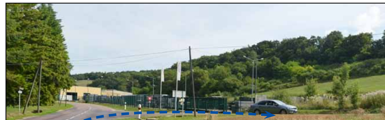
Figure 13: Vue 1 - Bifurcation de la D2 au niveau d'«Eurofence» à l'entrée de Doulevant
