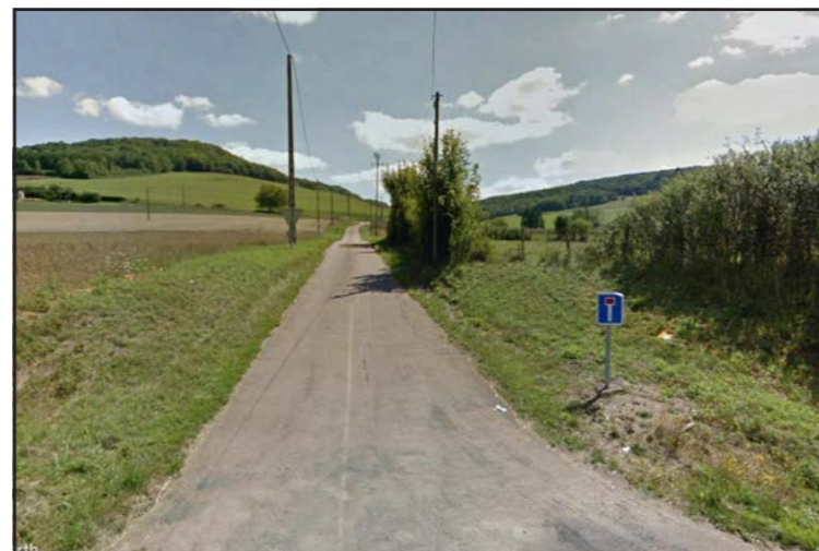
La RD9j à la jonction avec la RD905
