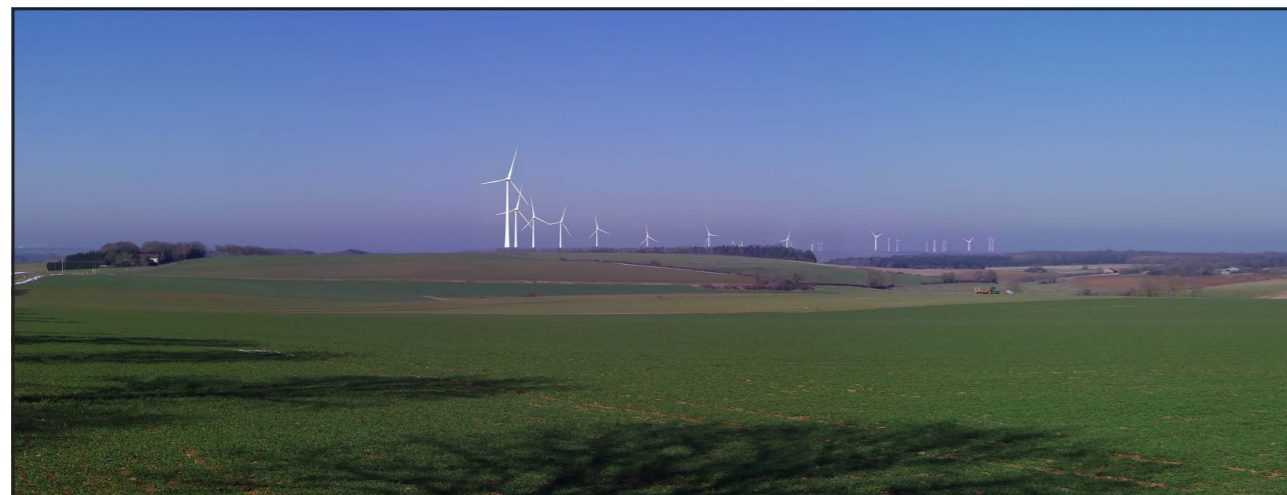
Figure RNT16 : Option 1 - 1.900 m du projet - Une ligne courbe de 10 éoliennes E-115 sur des tours de 92 m
