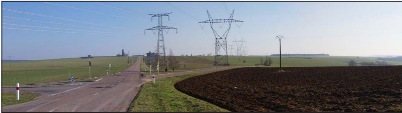
Vue 01 : lignes électriques à l'arrivée sur La Villeneuve-lès-Convers sur la RD19
