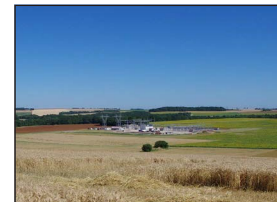
Poste électrique de Darcey
