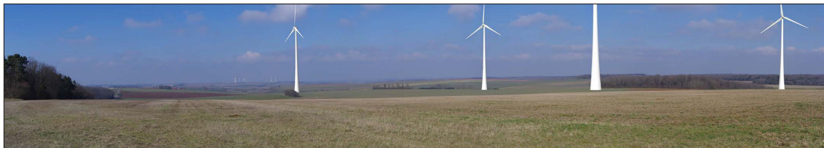
Figure 314: Panoramique P056 - le long de la RD19 à Darcey - 450 m de l'éolienne la plus proche
