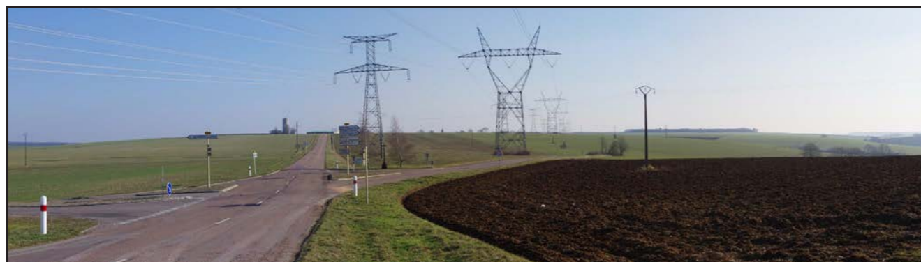
Figure 104: Vue 01 : lignes électriques à l'arrivée sur La Villeneuve-lès-Convers sur la RD19
