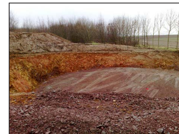
Figure 269: Réalisation des terrassements pour les fondations d'une éolienne
