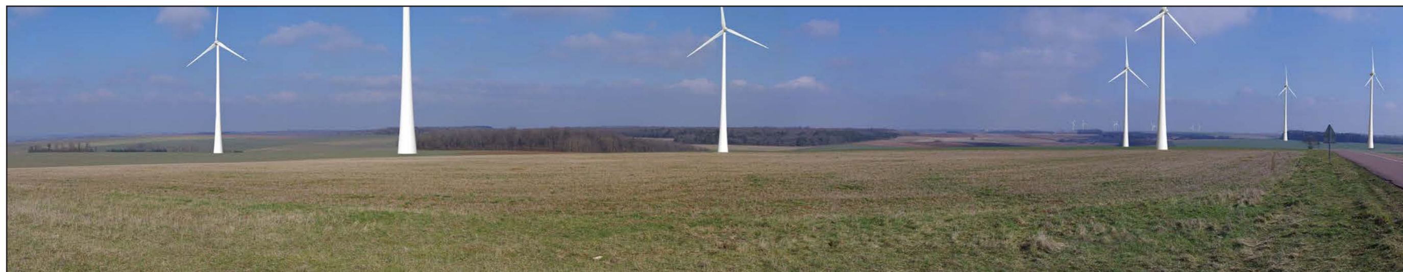
Figure 311: Panoramique P056 - le long de la RD19 à Darcey - 450 m de l'éolienne la plus proche
