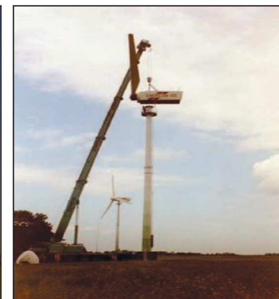
Figure 264: Démontage du rotor
