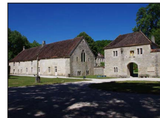
Figure 95: Porterie de l'Abbaye de Fontenay
