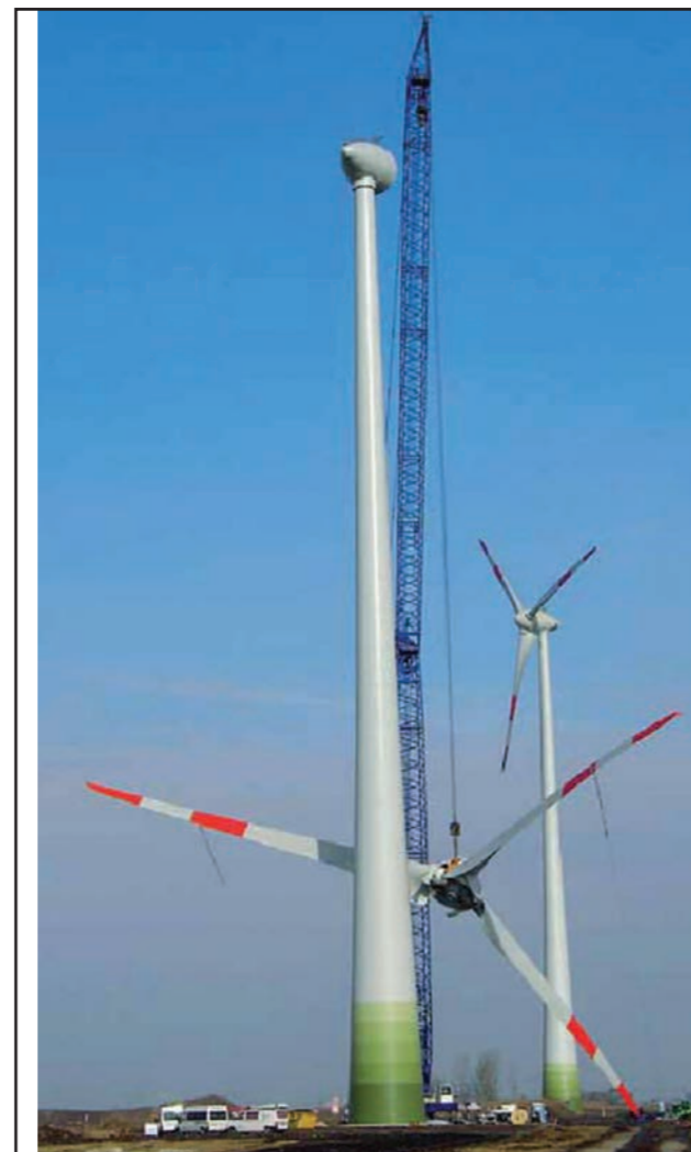
Figure 252: Montage du rotor
