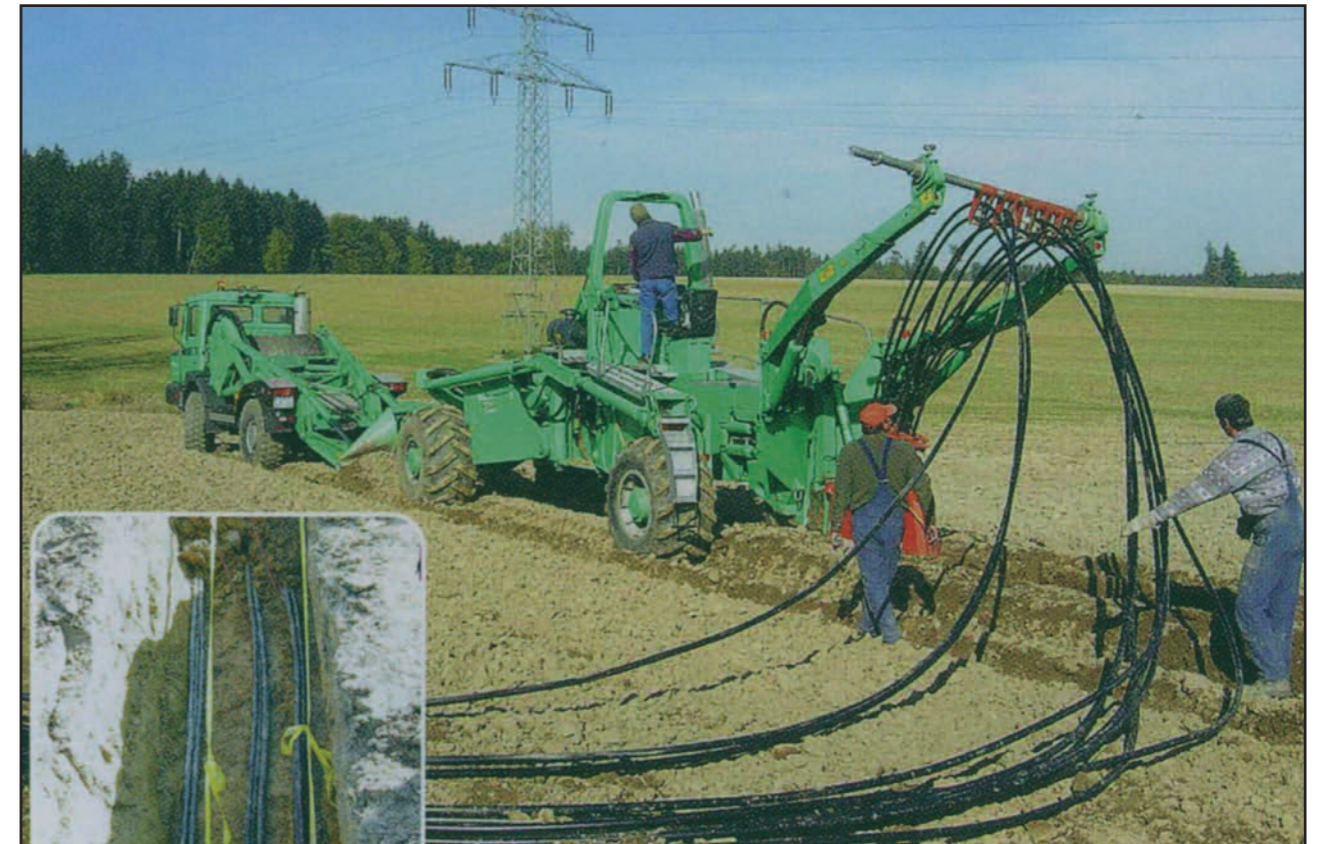
Figure 253: Machine pour enterrer les cables
