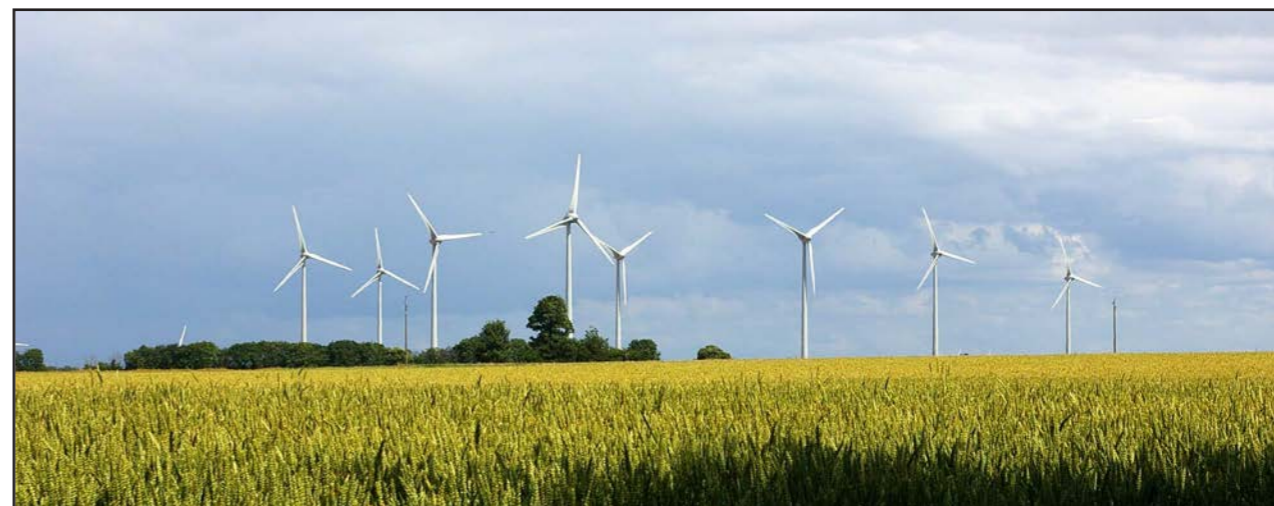
Figure 8: Parc éolien de Garcelles-Secqueville (16 MW), construit en 2008
