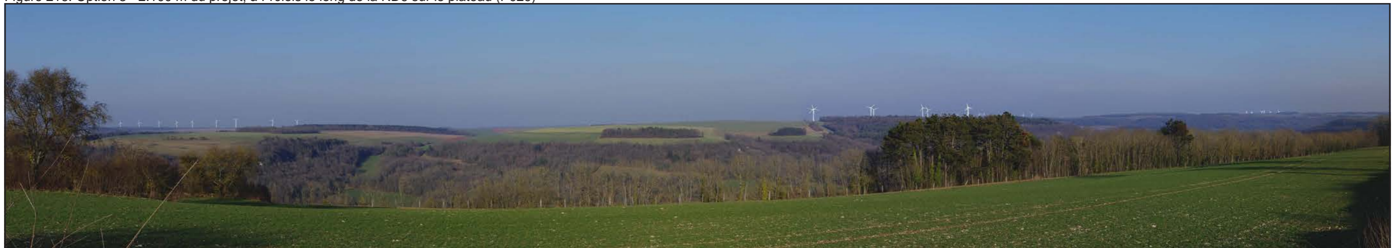
Figure 217: Option 3 - 7,3 km du projet, à Alise-Sainte-Reine sur le sommet du Mont Auxois (P012)
