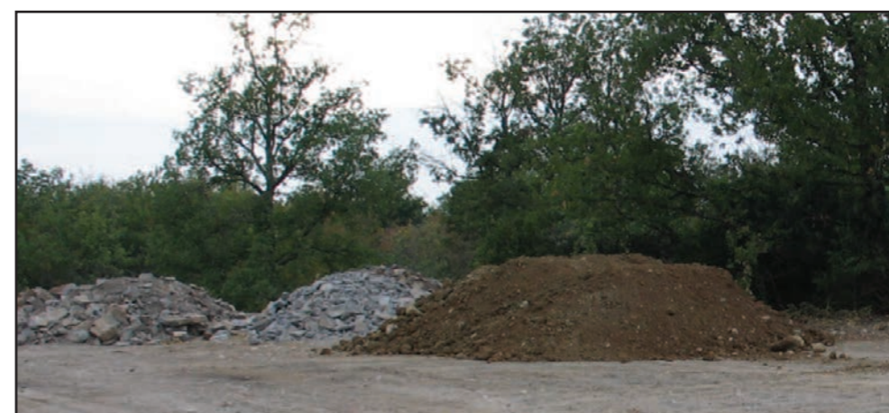
Figure 266: Séparation des différentes couches de terres extraites
