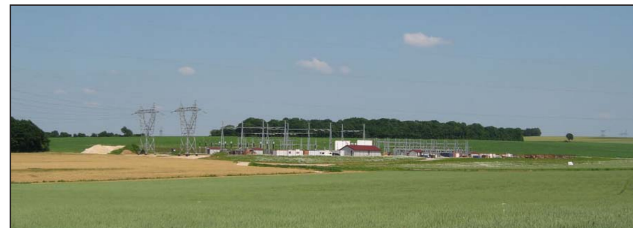
Figure 260: Poste de raccordement de Darcey en construction
