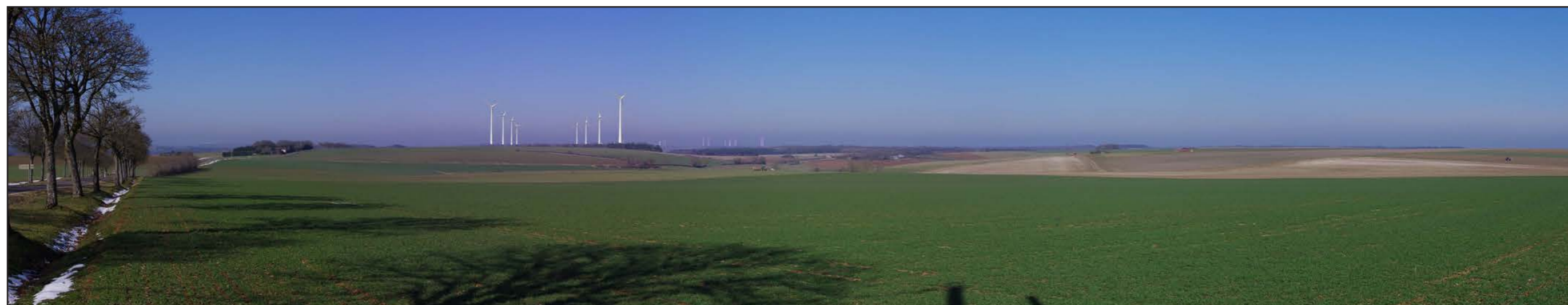
Figure 333: Panoramique P029 - sur le plateau au-dessus de Frôlois sur la RD6 - 2,1 km de l'éolienne la plus proche
