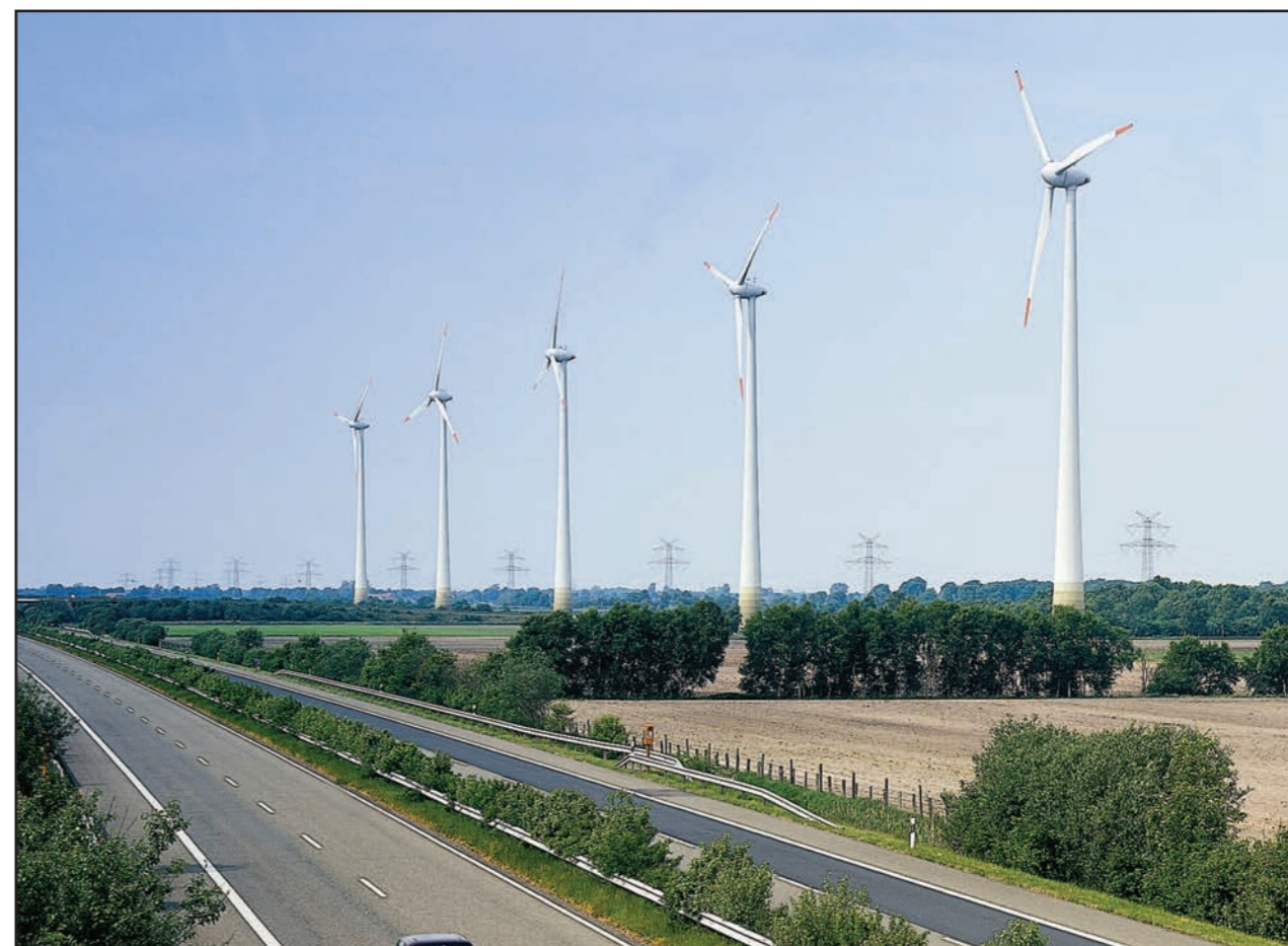
Figure 6: Le parc éolien de Borsum (Enercon E70, hauteur totale 133 mètres), réalisé par le groupe DGE
