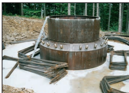
Figure 246: Noyau de la fondation
