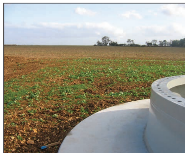
Figure 256: Bord de la fondation recouvert de terre végétale et cultivable
