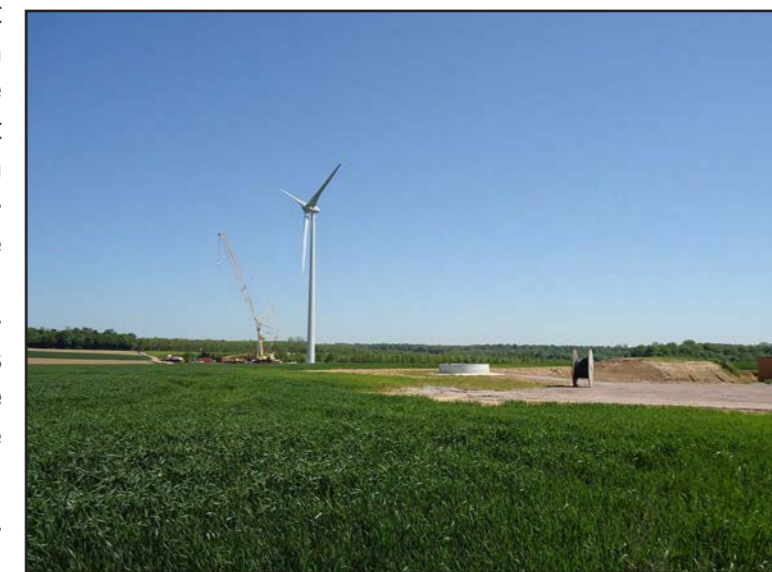
Figure 13: Travaux du projet de « Sachin », parc de 4 éoliennes en cours de réalisation
