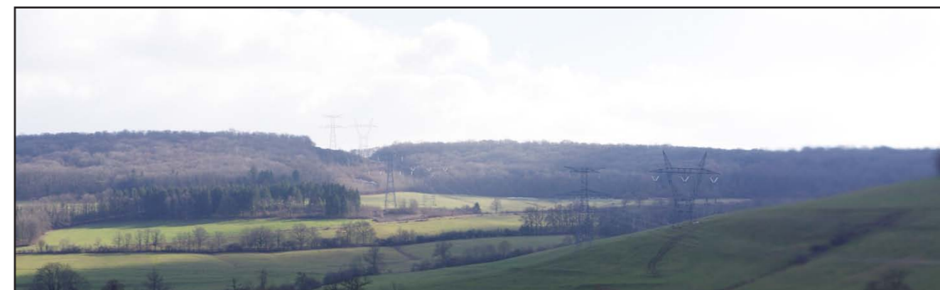
Figure 156: Ligne électrique 400 kV enjambant la vallée de l'Oze à Thenissey
