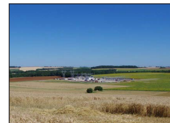
Figure 157: Poste électrique de Darcey
