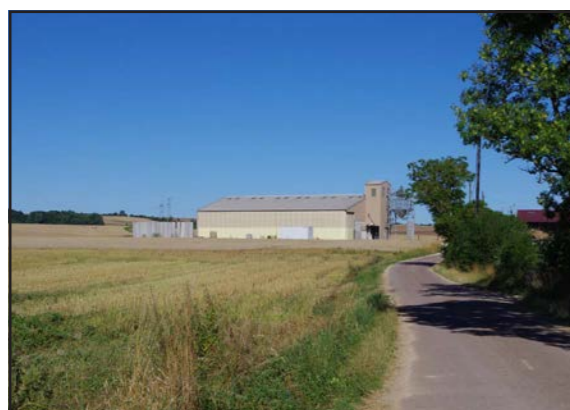
Figure 164: Silos à Chaume-lès-Baigneux
