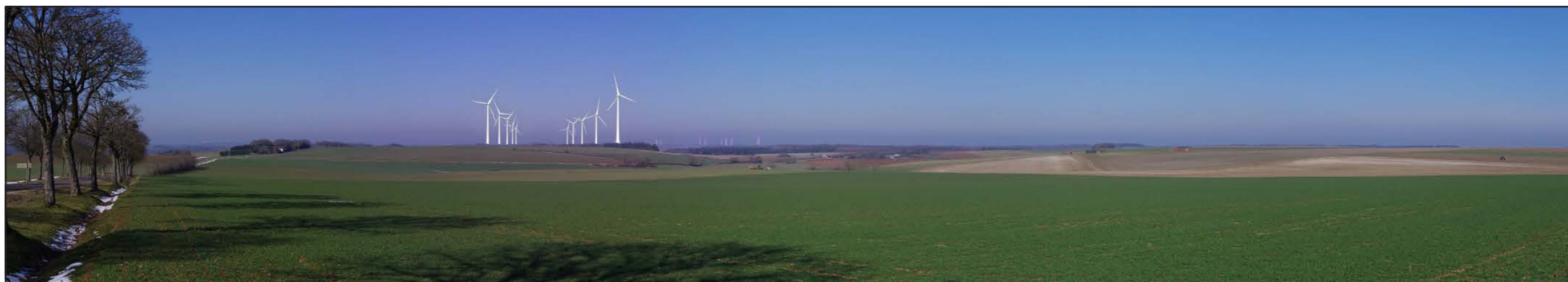
Figure 206: Option 2bis - 2.100 m du projet - Deux lignes droites parallèles 5 éoliennes E-115 sur des tours de 149 m
