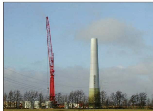
Figure 250: Montage des tours
