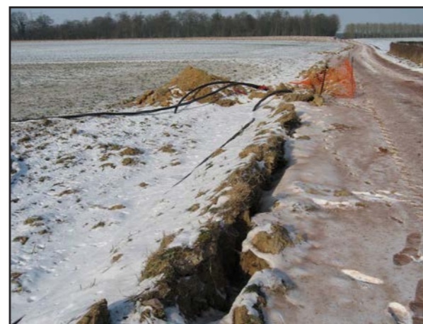
Figure 268: Réalisation d'une tranchée à câbles souterrains
