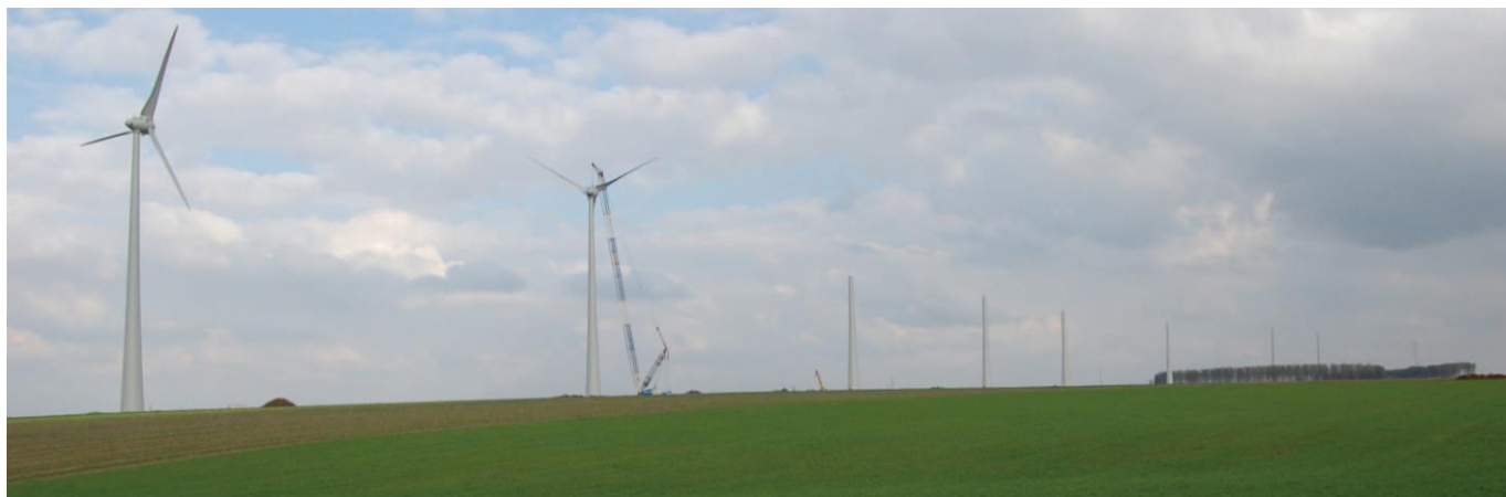
Photo 4 : Travaux du projet « Le Nouvion », parc de 24 éoliennes (Source : Intervent)
