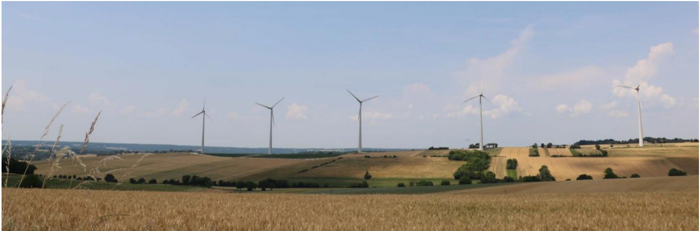
Photo 2 : Parc éolien de Bouby (11,5MW) construit en 2017 (Source : Intervent)
