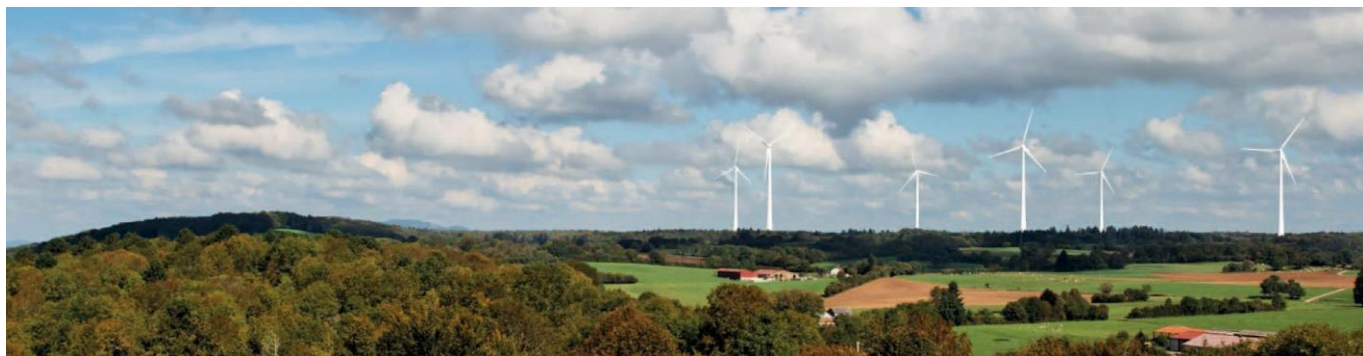
Photo 3 : Parc éolien de Chamole (18MW) construit en 2017 (Source : Intervent)
