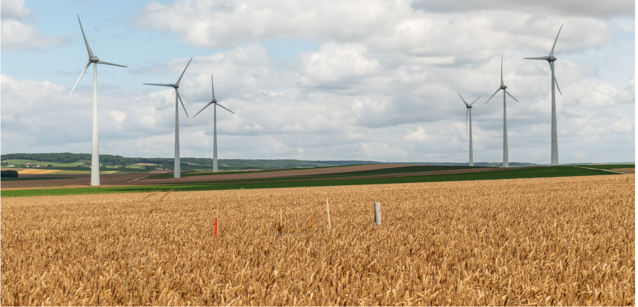
Le parc éolien « La Saronde » d'Alterric, au cœur des champs de céréales de la Marne. Au premier plan, devant les éoliennes, une cage de protection installée pour sécuriser un nid de busards. Photo : © Alterric \ Boris de Wolf
