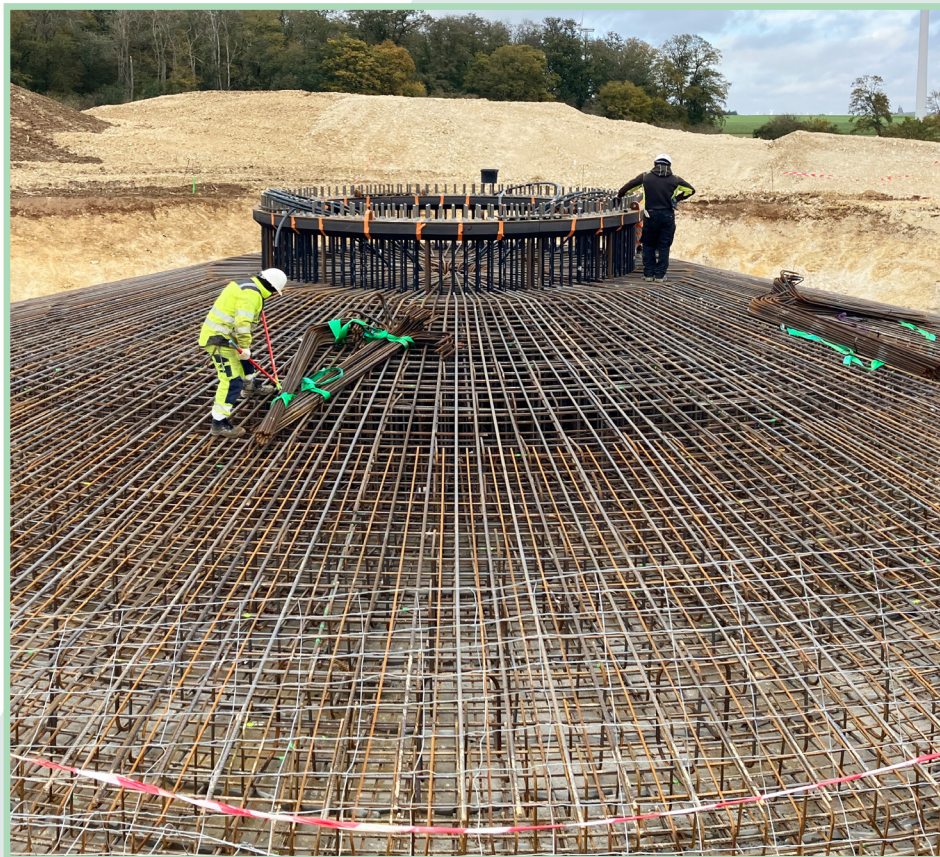
Fondation en cours de ferrailage - 2023 © Alterric
