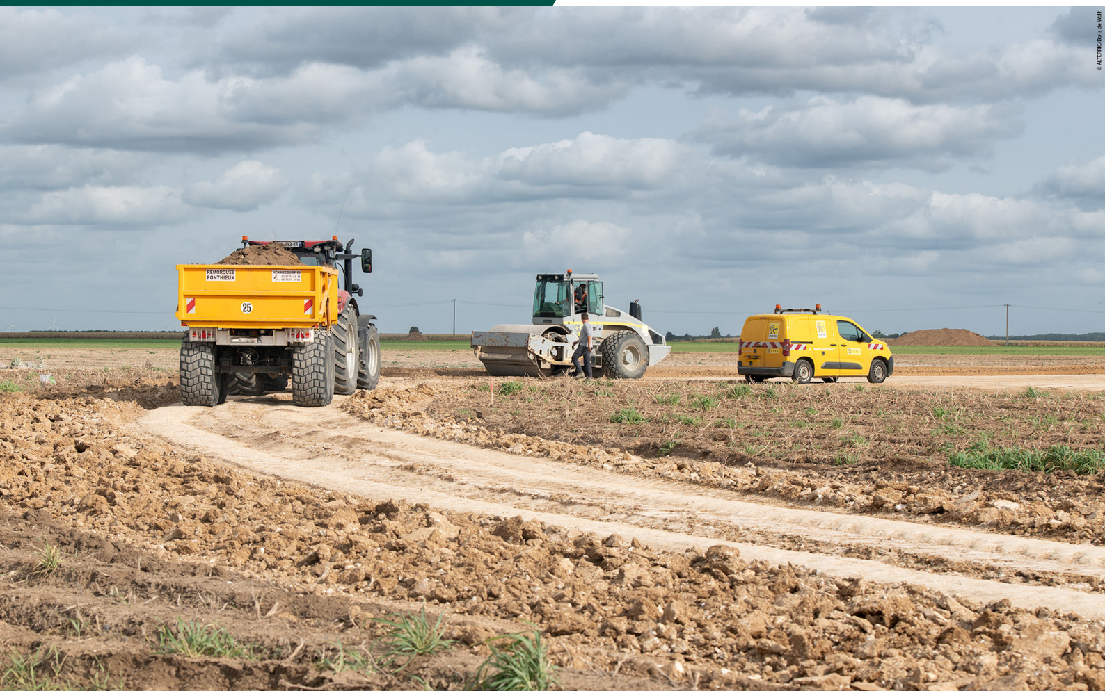
Chemins d'accès et aire de grutage en cours d'aménagement - 2023 © Alterric
