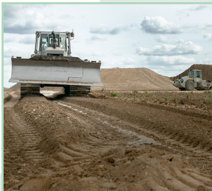
Aire de grutage en cours d'aménagement - 2023 © Alterric
